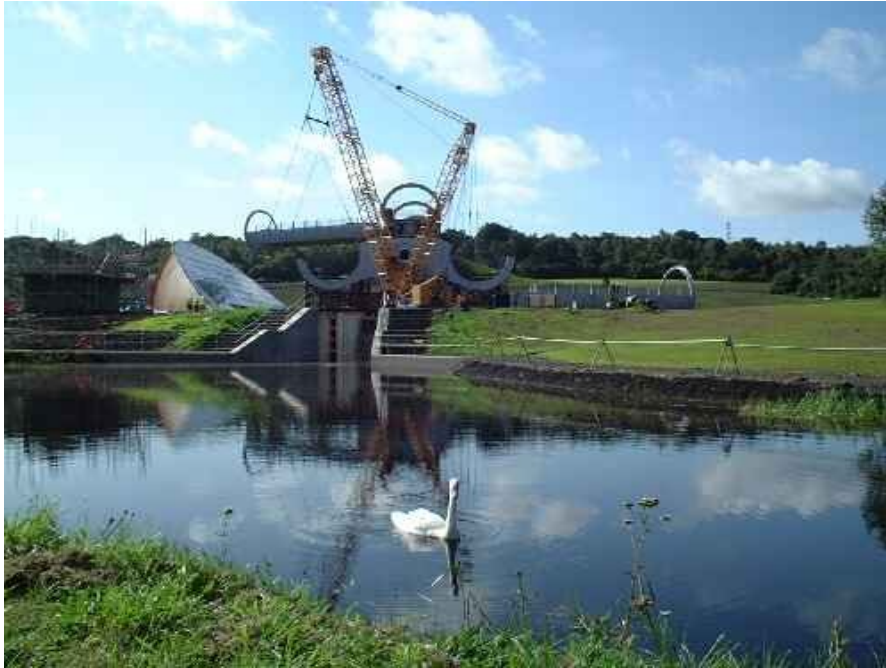
Falkirk Wheel in der Bauphase
