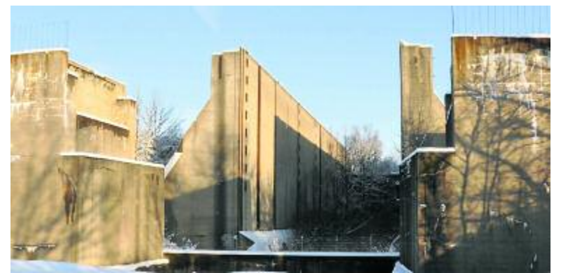
Unvollendet: die Schleusenruine in Wüsteneutzsch.
